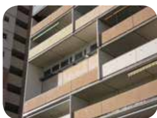
Loggien vor der Sanierung
