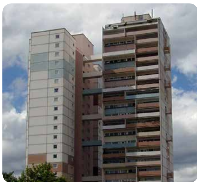
Das Gebäude vor der Sanierung...
