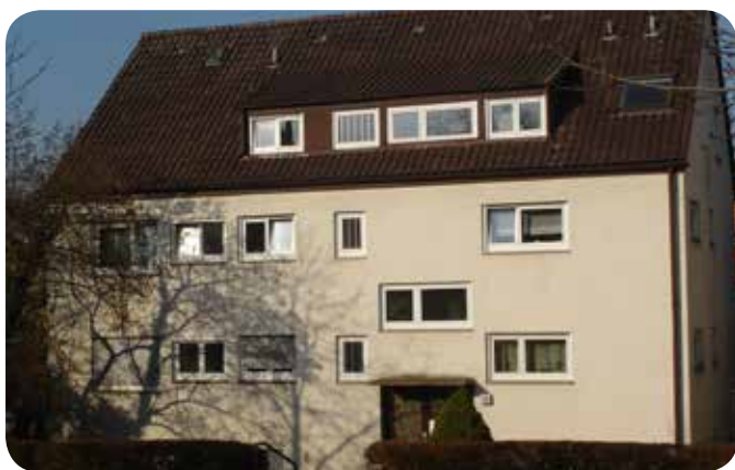
Das Gebäude vor der Sanierung...
