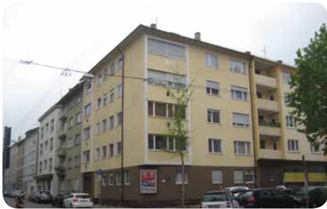
Das Gebäude vor der Sanierung...
