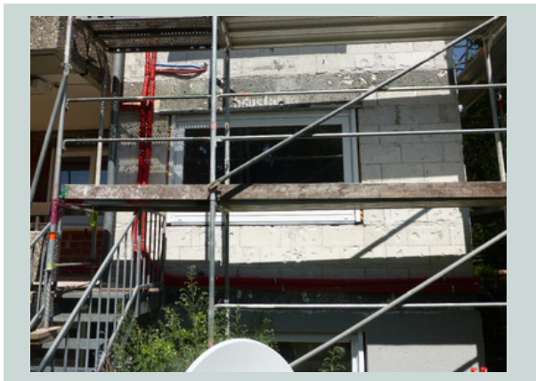
Abb.3 Hinteransicht des Gebäudes in Bauphase
