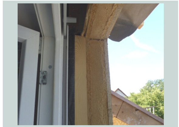
Abb.4 Dämmschichten der Außenwand
