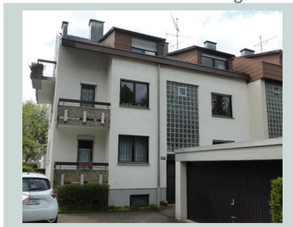
Abb.2 vor der Sanierung
