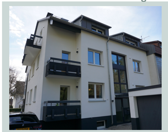
Abb.1 nach der Sanierung
