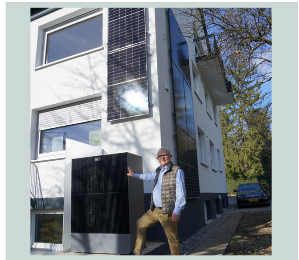
Abb.5 Bauherr vor der Außeneinheit der Wärmepumpe mit Fassaden-PV-Anlage
