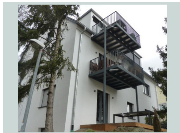
Abb.5 Seitenansicht des Gebäudes (nachher)
