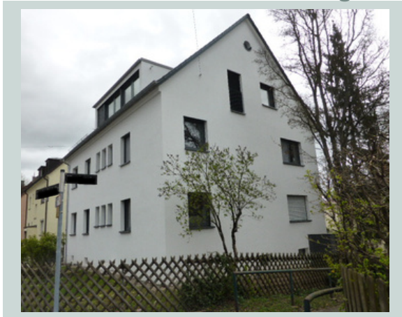
Abb.1 nach der Sanierung
