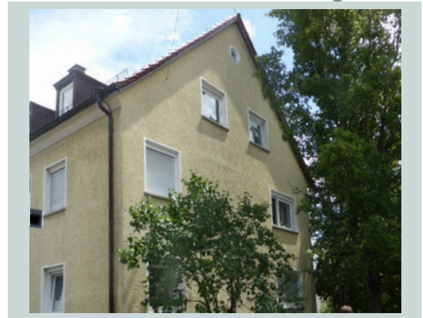
Abb.2 vor der Sanierung
