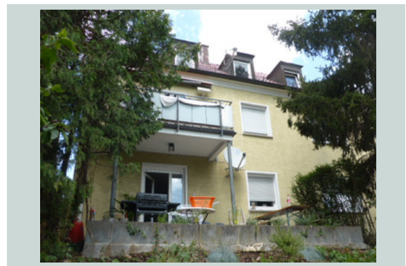
Abb.4 Seitenansicht des Gebäudes (vorher)
